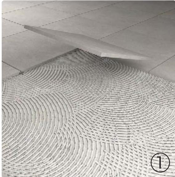
Iniziare con la stesura omogenea del collante per esterno seguendo le norme specifiche dell'adesivo utilizzato e procedere con la posa delle lastre.
