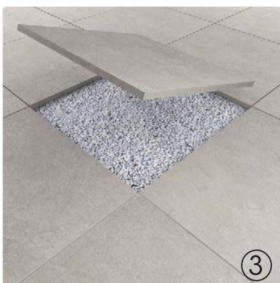
Posizionare la lastra sullo strato di ghiaia o sabbia e battere con un martello di gomma la superficie per eliminare i dislivelli.
